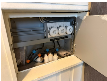
Ikke tilstrekkelig festet strømkabel.
