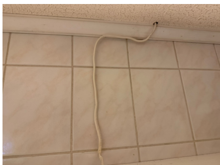
Ikke tilstrekkelig festet strømkabel.
