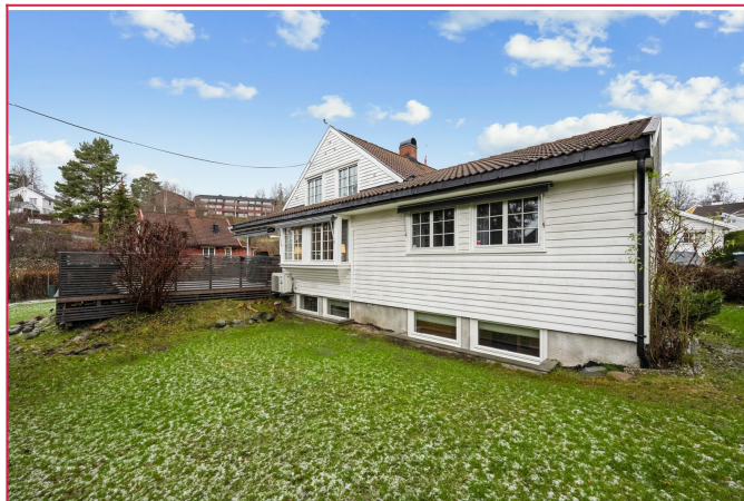
Fasade - sett fra hagen
