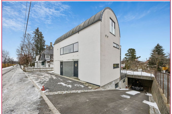
Husets fasade. Nedkjørselen til garasje er oppvarmet
