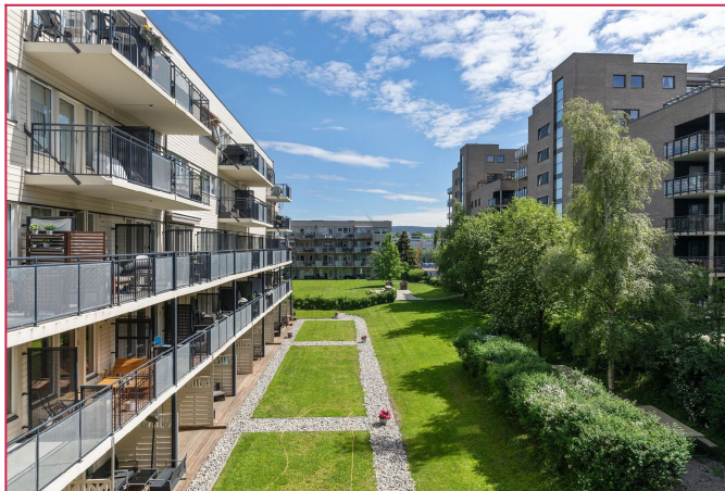
Pent opparbeidet fellesareal.
