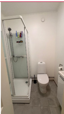
Flislagt bad(gulv) med varmekabler. Dusjkabinett, toalett og servant med underskap.
