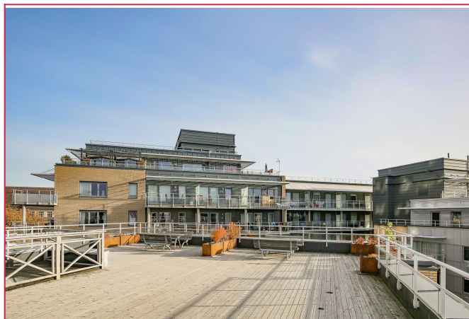
Tilgang til felles takterrasse
