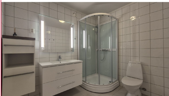
Her er det varmekabler i gulvet.
