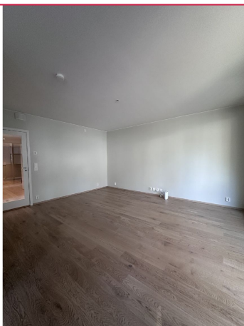
Stue - Varme i gulvet, oppvarmet av vannbåren gulvarme
