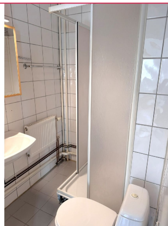
Flislagt bad. Felles vaskerom i kjeller
