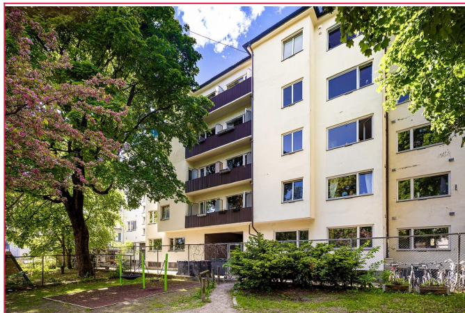
Fasade fra bakgård
