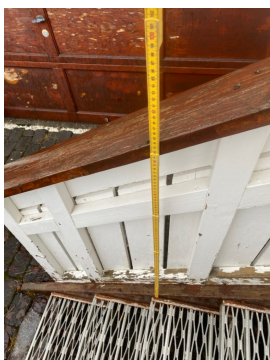
Høyde rekkverk på trapp ved entre.
