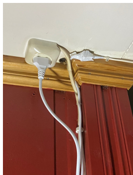
Utett rundt gjennomføringer i skapet.
