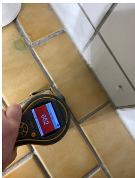
Fuktmåling av overflate på bad.
