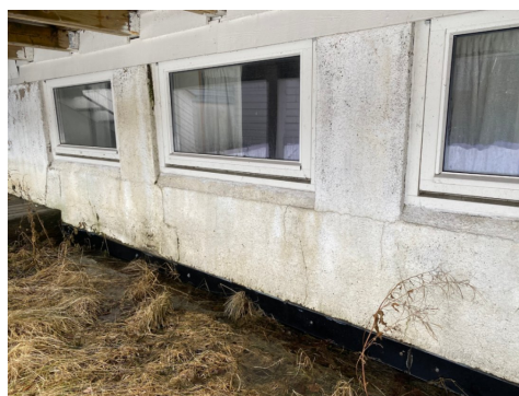
Vinduer til stue i kjelleretasje.
