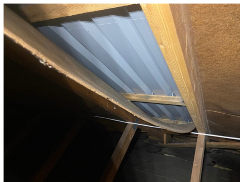
SU- plater/undertak som har løsnet fra taksperre.
