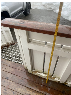
Slitt ballongdekket og rekkverk.
