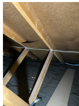
SU- plater/undertak som har løsnet fra taksperre.
