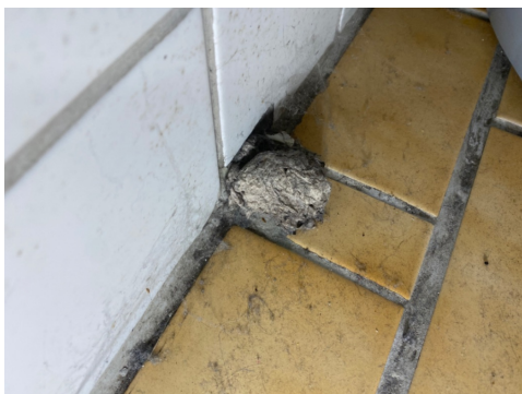
Avløpsrør mot gulv på bad i kjeller.
