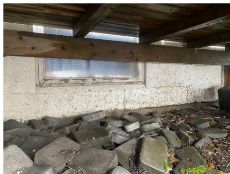
Vindu til bad i kjelleretasje.
