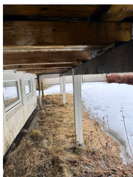
Det er registrert fall mot boligen. Stedvis mye stående vann mot grunnmur.
