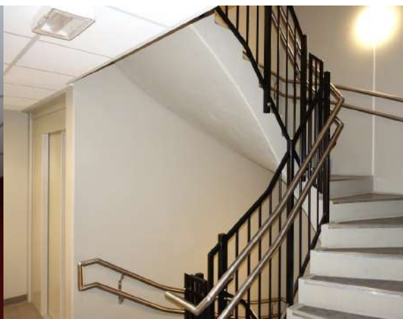
Eksempelbilde innvendig i fellesareal.
