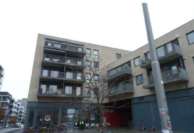
Vinduer i fasade.
