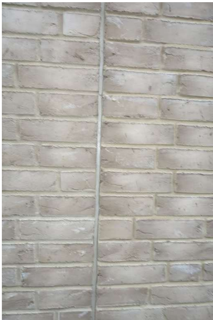
Dilatasjonsfuge på fasade.
