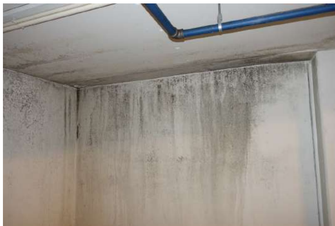
Mugg på vegg og himling i nedre del av p-kjeller.
