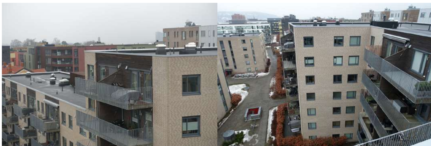
Fasade med konstruksjoner av betongelementer og bindingsverk.
