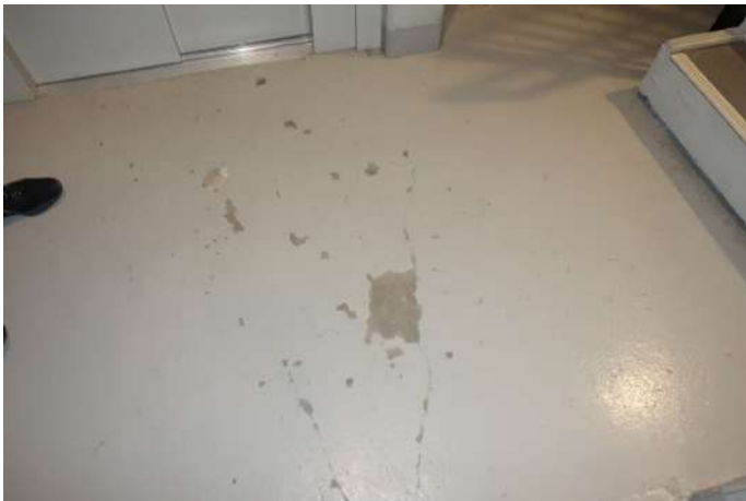
Noe malingsflassing på gulv.
