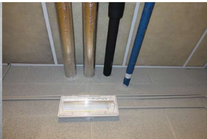
Branntetting rundt gjennomføringer.
