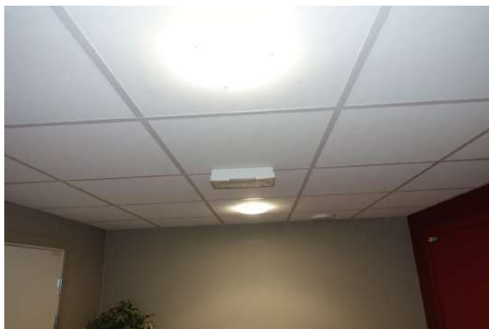
Eksempelbilde innvendig i fellesareal.
