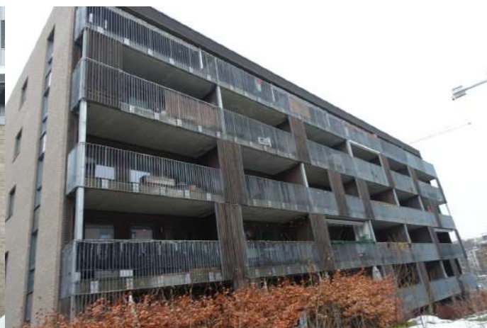
Deler av fasade med trekledning.
