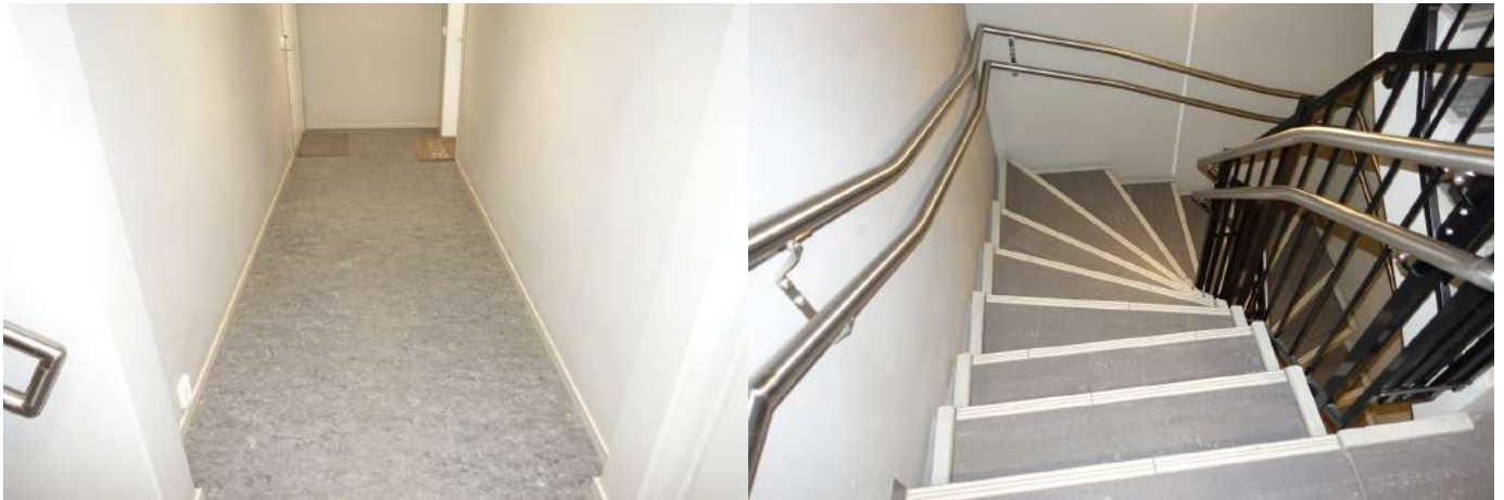
Oppganger med gulvbelegg.
