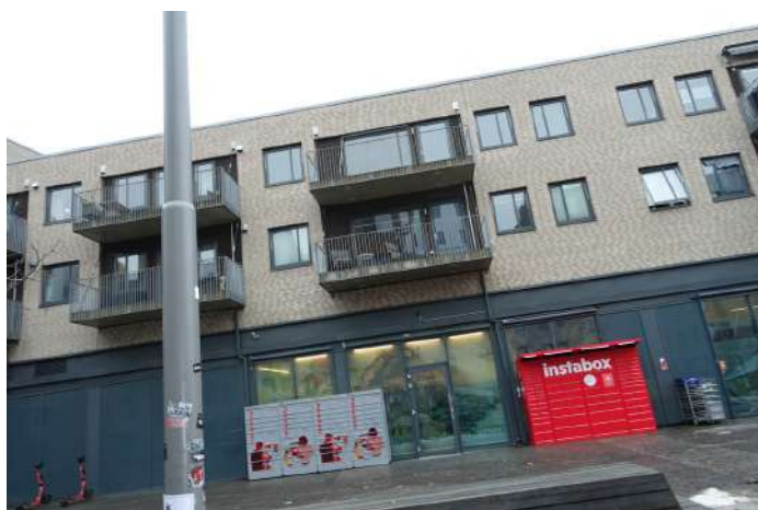
Vinduer i fasade.
