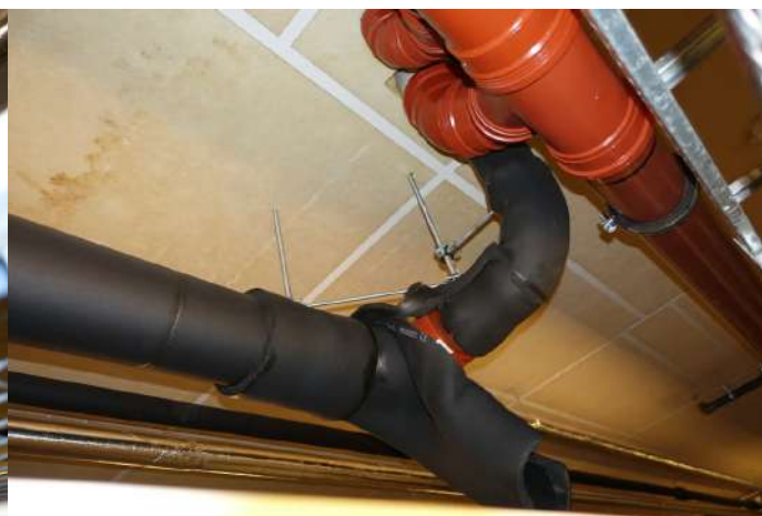
Bend som er sikret/tillegg klamret.
