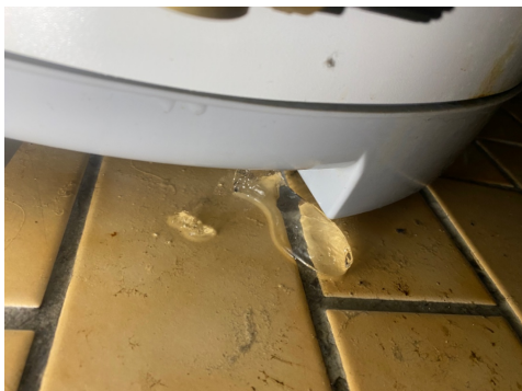
Tegn til lekkasje.
