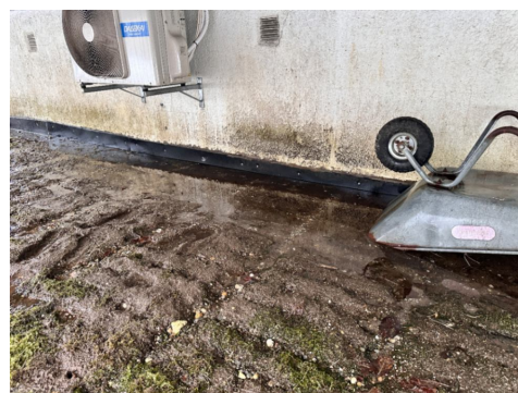
Fuktsikring mot mur.
