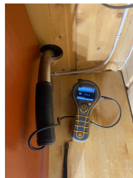
Fuktmåling i skillevegg mot bad.
