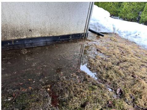
Det er registrert fall mot boligen. Stedvis mye stående vann mot grunnmur.
