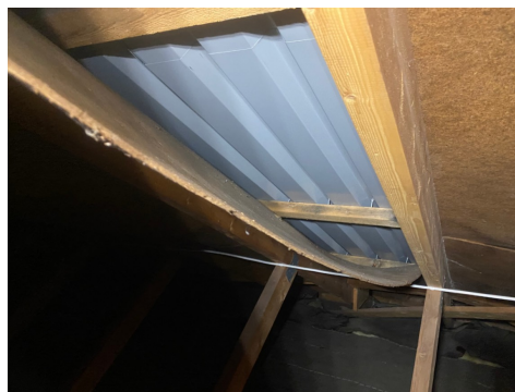
SU- plater/undertak som har løsnet fra taksperre.
