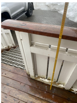
Slitt ballongdekket og rekkverk.
