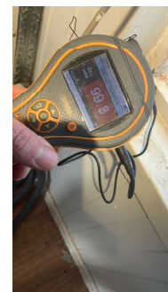
Høye fuktverdier måles stedvis i vinduskarmen
