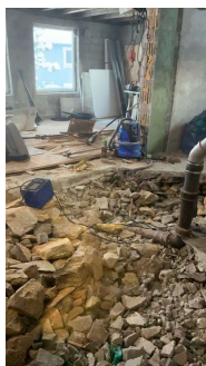
Full opparbeidelse av kjeller må påregnes, da det er påbegynt renovering.
