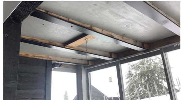
Enkel tetting mot fukt fra terrasse over.
