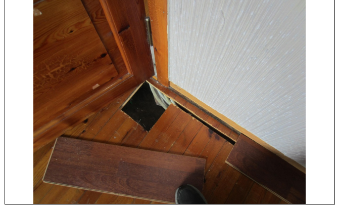
Holtaking i golv for framføring av installasjon.
