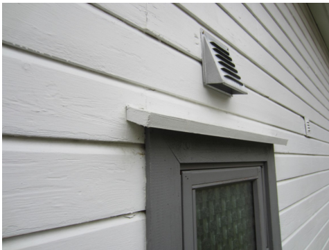
Døme på vindauge utan beslag i overnag vegg-vindauge.
