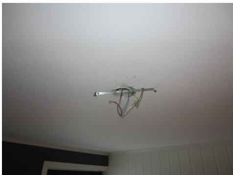
Lause kablar, uisolerte
