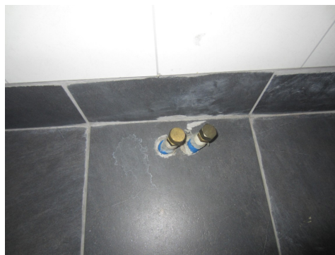
Ikkje synleg membran ved røyroppstikk
