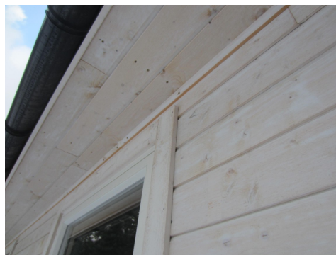
Tett lufting ved raftekasse
