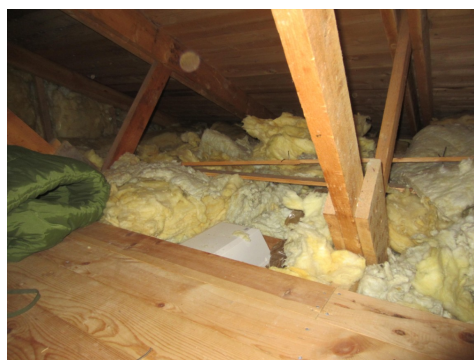
Avstand over 60 cm som er normalt for takstolar av denne type.
