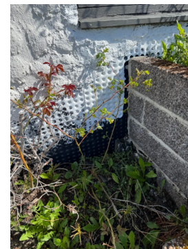
Stedvis synlig grunnmursplast.
