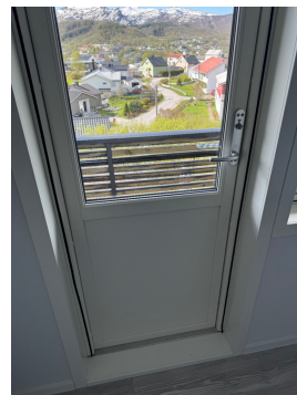
Balkongdør på hovedsoverom, skiftet i 2017.
