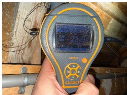
Høye fuktverdier på kaldloft
