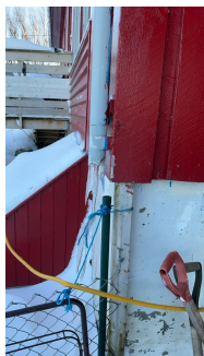
Skader på renner og nedløp registreres.
