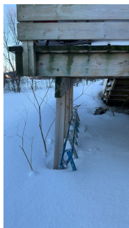
Utvendig tretrapp samt paller ved inngangsparti
