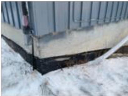
Taknedløp ført ned ved grunnmuren.
