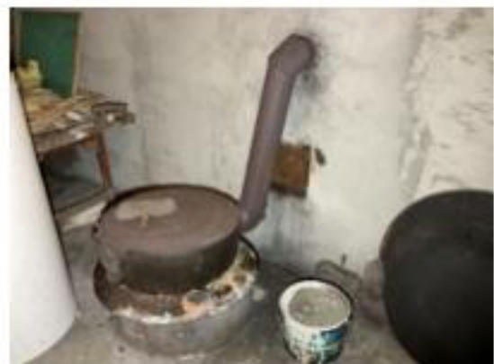
Sotluke bak takke i kjelleren.
