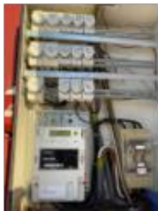
Mangler deksel på koblingsboks.
