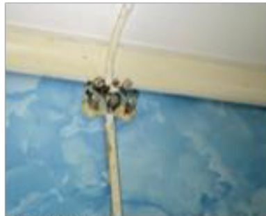
Mangler deksel på koblingsboks.
