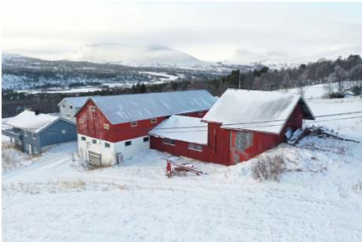
Driftsbygning med siloer
