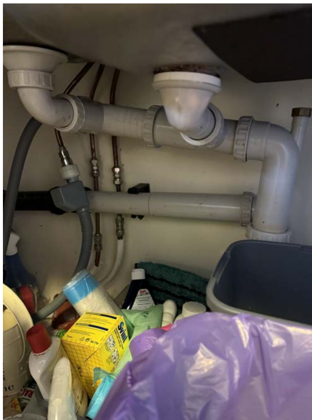
Synlige vann - og avløpsrør i oppvaskbenken.
