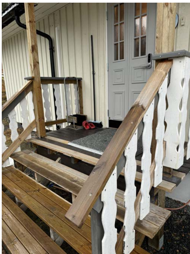
Overbygget veranda foran inngangsdøren i 1. etasje. Rekkverk i tre med en høyde på 90 cm.
