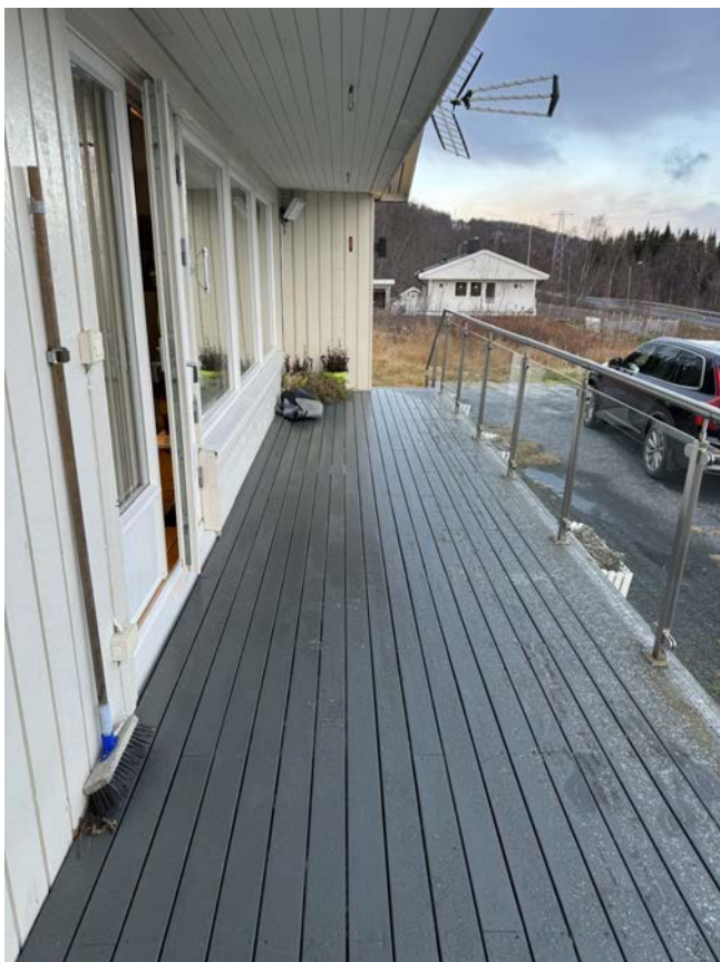
Delvis overbygget veranda med adkomst fra stuen og bakkenivå med rekkverk i glass.
