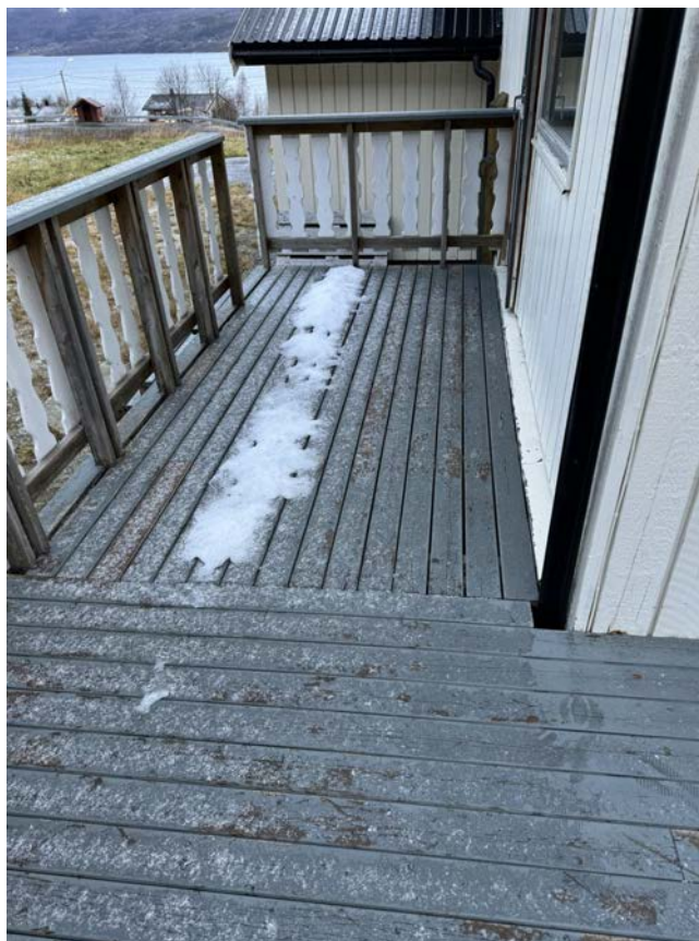
Veranda med adkomst fra et av soverommene og bakkenivå med rekkverk i tre med en høyde på 90 cm.
