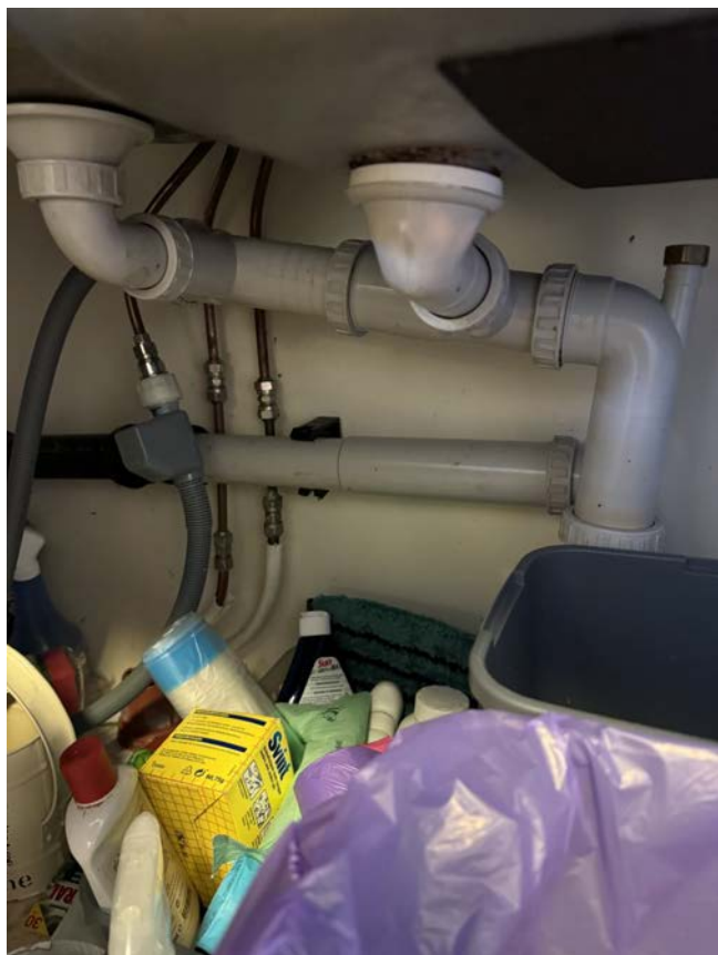
Synlige vann - og avløpsrør i kjøkkenbenken.
