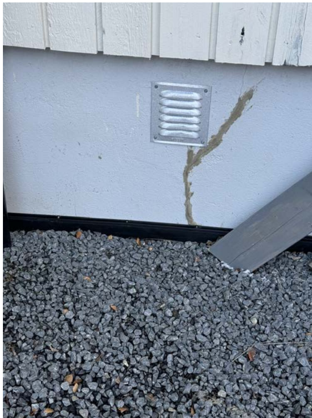
Grunnmur av betong stein som er pusset og malt på utsiden
