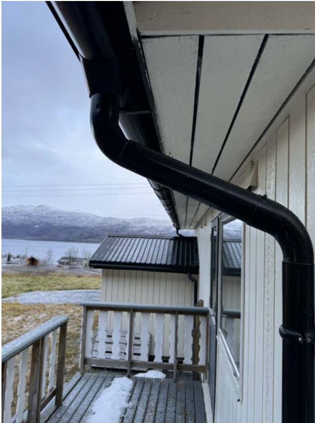
Takrenner, nedløp og beslag i metall.
