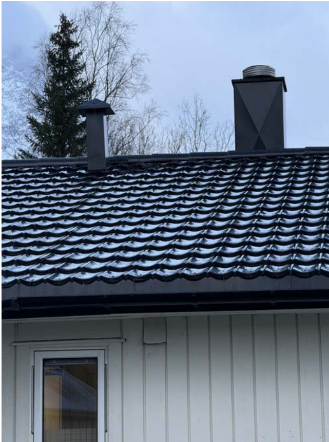
Taktekke med metall plater.
