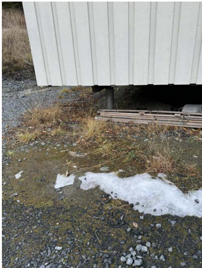
Betong pilarer på tilbygg.
