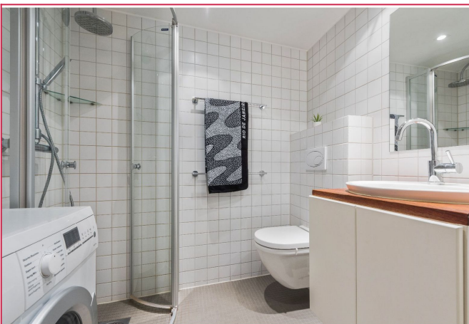
Bad med varmekabler, vaskemaskin og downlights i tak.
