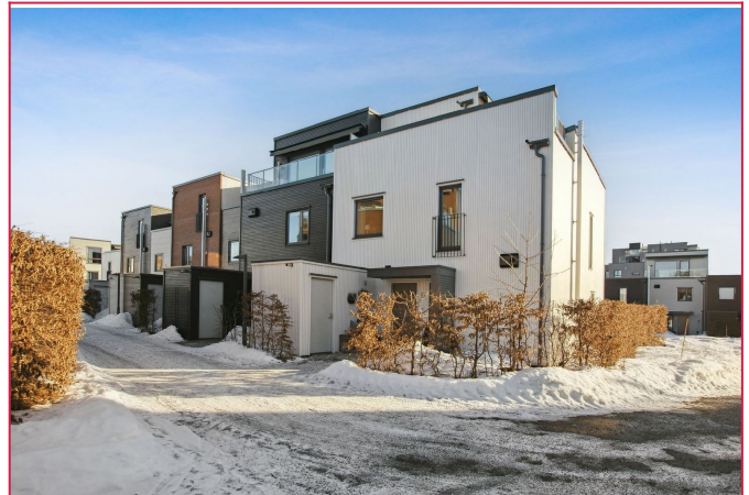
Nyere bolig med hele 3 boder og teknisk rom. Den er også utstyrt med balansert ventilasjon.
