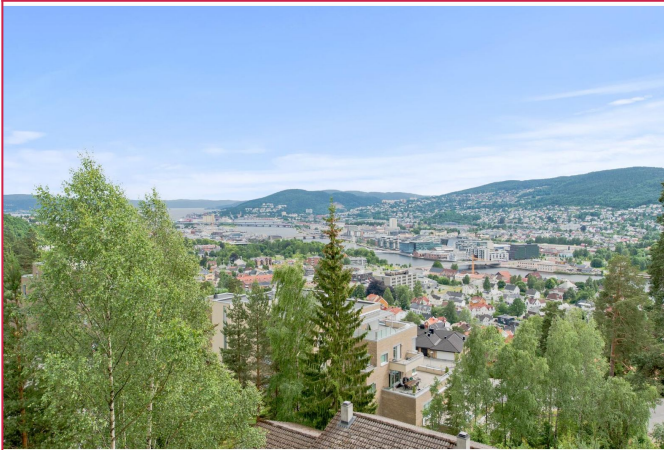
Utsikt fra bygget.
