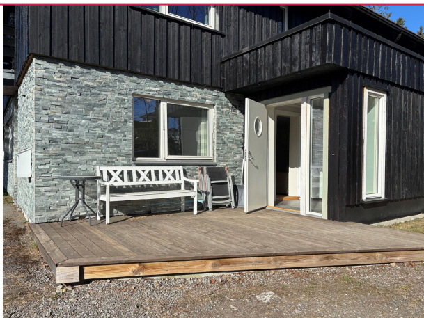
Platting utenfor inngangsparti
