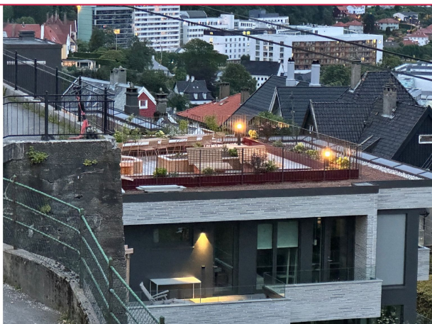
Felles takterrasse med nydelig utsikt over Bergen by.
