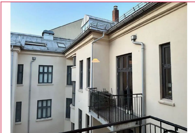
Balkong sett fra utsiden
