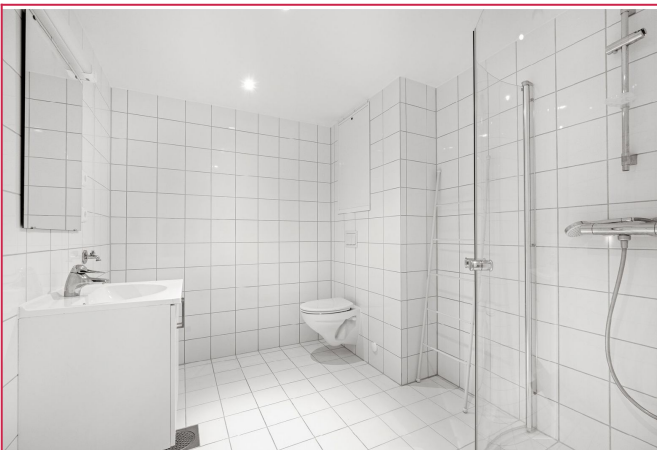
Flislagt bad med vegghoppengt kloset og dusj
