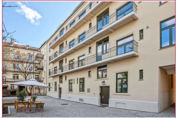
Bakgård med sittegruppe, sykkelparkering og felles brannbalkonger
