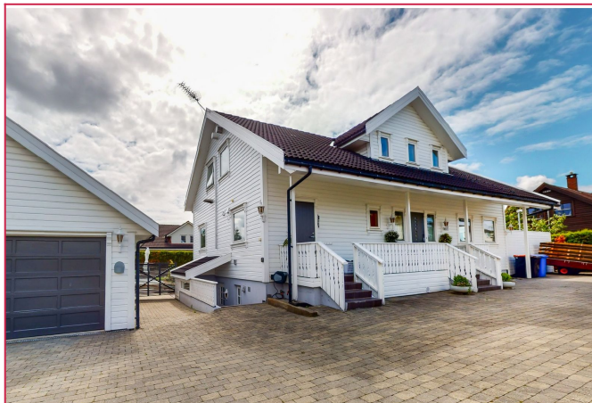
Fasade - gårdsrom med belegningsstein.
