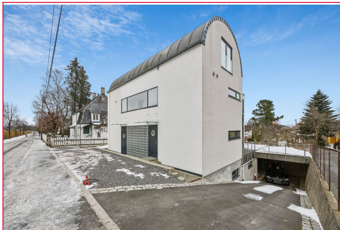
Husets fasade. Nedkjørselen til garasje er oppvarmet
