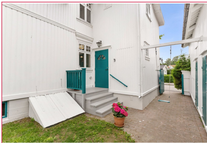
Trivelig inngangspart som er felles med leietakere i 1. etasje.
