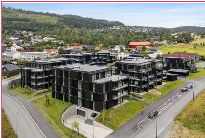
Dronefoto av bebyggelsen. Gjesteparkeringer langs vegen.
