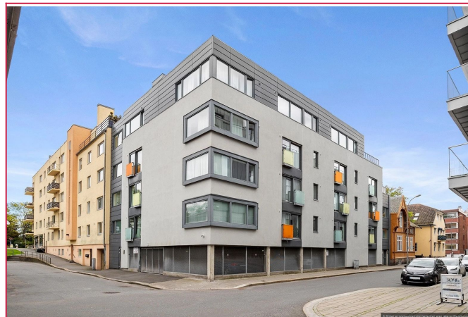
Fasade - inngang mellom det grå bygget og bruen.
