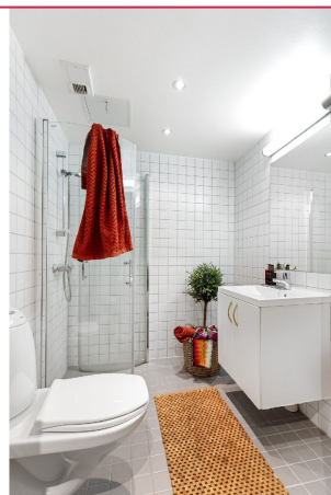
Moderne flislagt bad med opplegg for vaskemaskin
