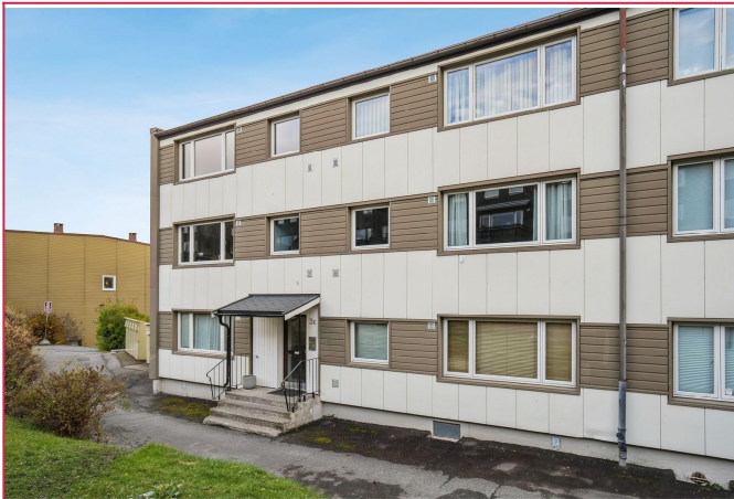
Fasade - leiligheten ligger på 2 etasje -
