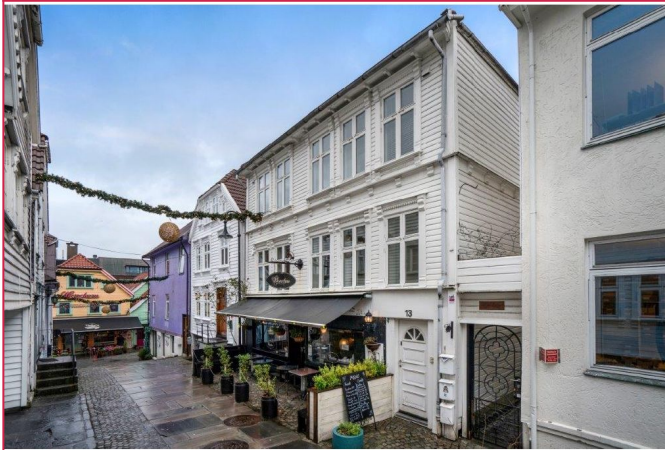
Fasade, leiligheten ligger i 2.etg
