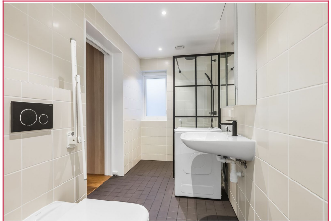
Nyoppusset bad med vaskemaskin, dusj, WC og servant.
