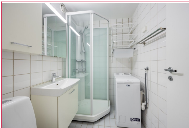
Filagt bad med varmekabler og vaskemaskin
