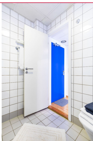
Flislagt bad med varmekabler
