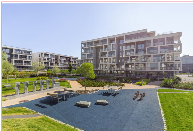
God plass og pent opparbeidede arealer utenfor
