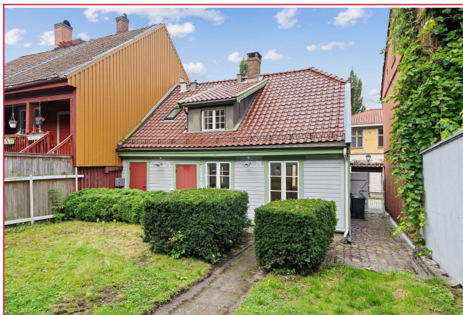
Felles hage/bakgård med Skippergata 3
