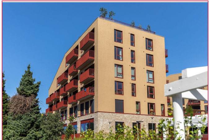
Fasadebilde - Leiligheten ligger i 4.etg.
