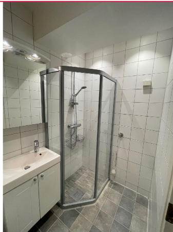
Bad med opplegg til vaskemaskin
