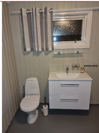
Det er installert vaskemaskin på badet.
