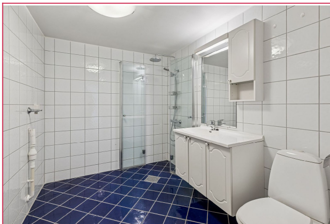
Flislagt bad med varmekabler
