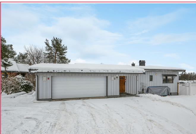
Fasade. Hybelen har inngang på bakside av garasje
