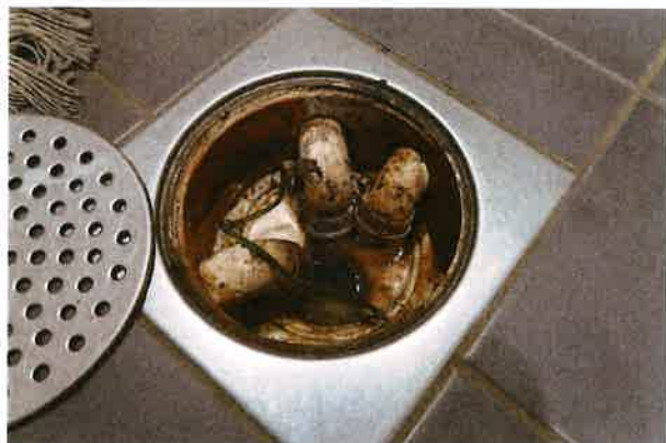
Hovedsluk var dårlig rengjort, men det er synlig banemembran
