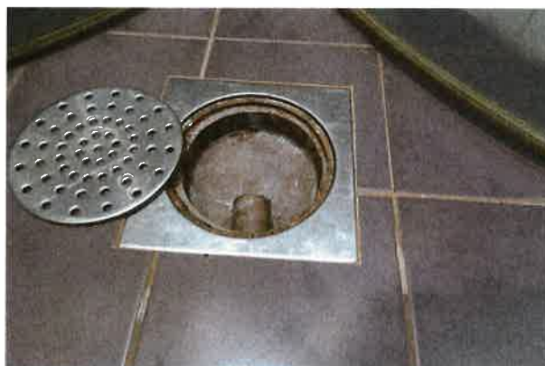
Hjelpesluk i dusjen med avrenning til hovedsluk.
