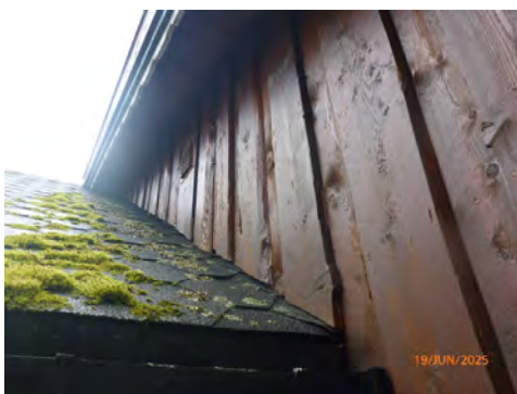
Vegg på tilbygget over opprinnelig tak.
