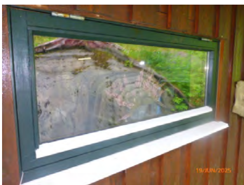
Vinduer fra rundt byggeår.
